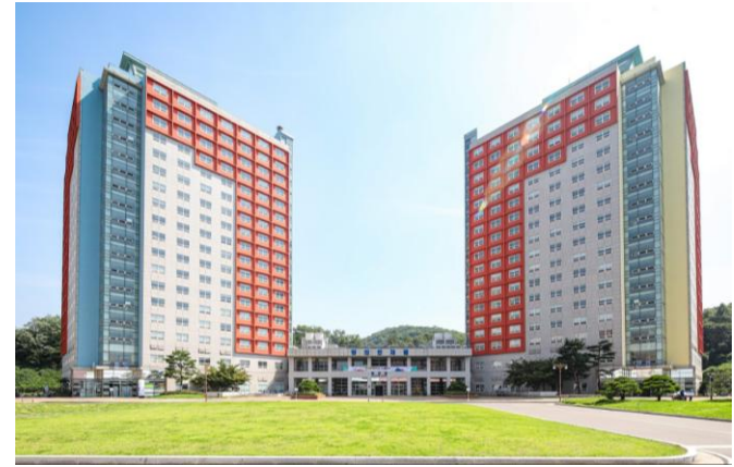
기숙사 宿舍 Dormitory
