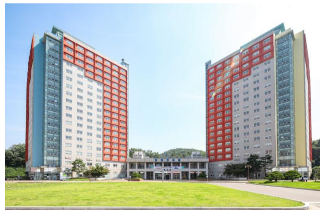
기숙사 宿舍 Dormitory
